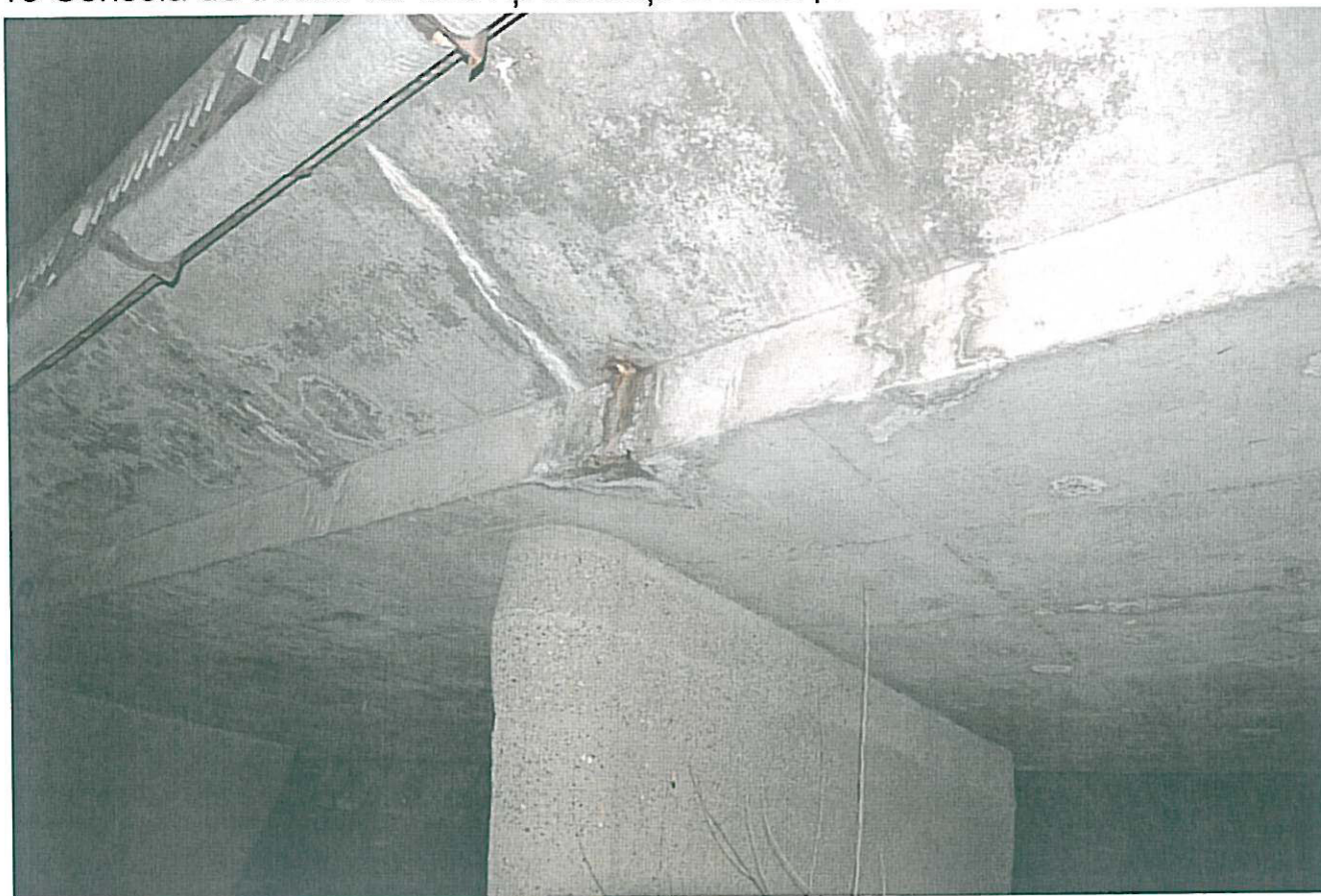
13 Consola de trotuar cu fisuri și infiltrații în zona pilei
