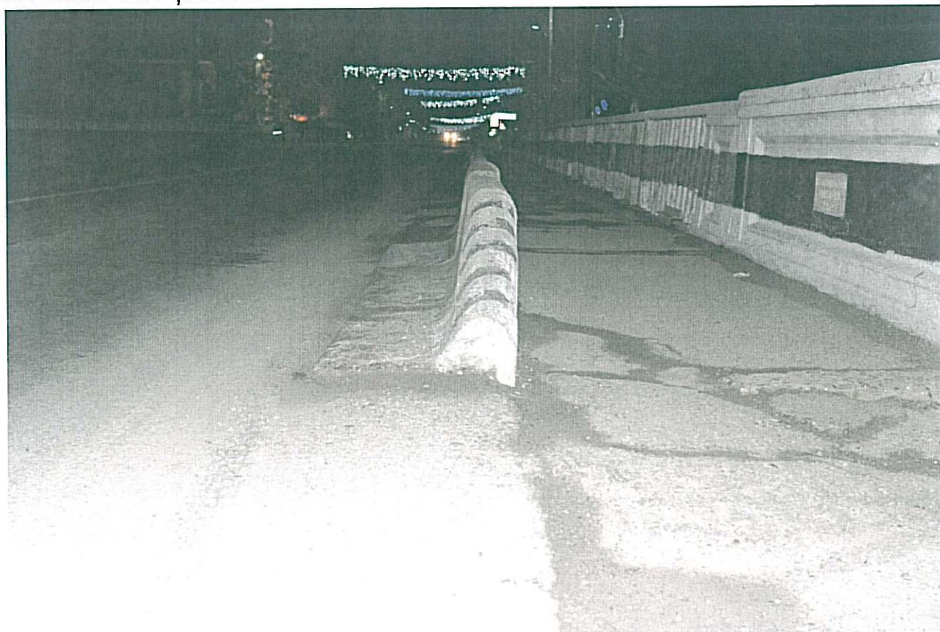
8.Vedere cale și trotuar
