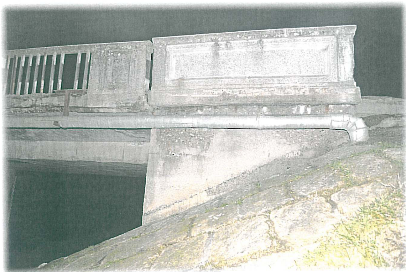
1. Vedere culee și sfert de con protejat cu pereu din dale de piatră
