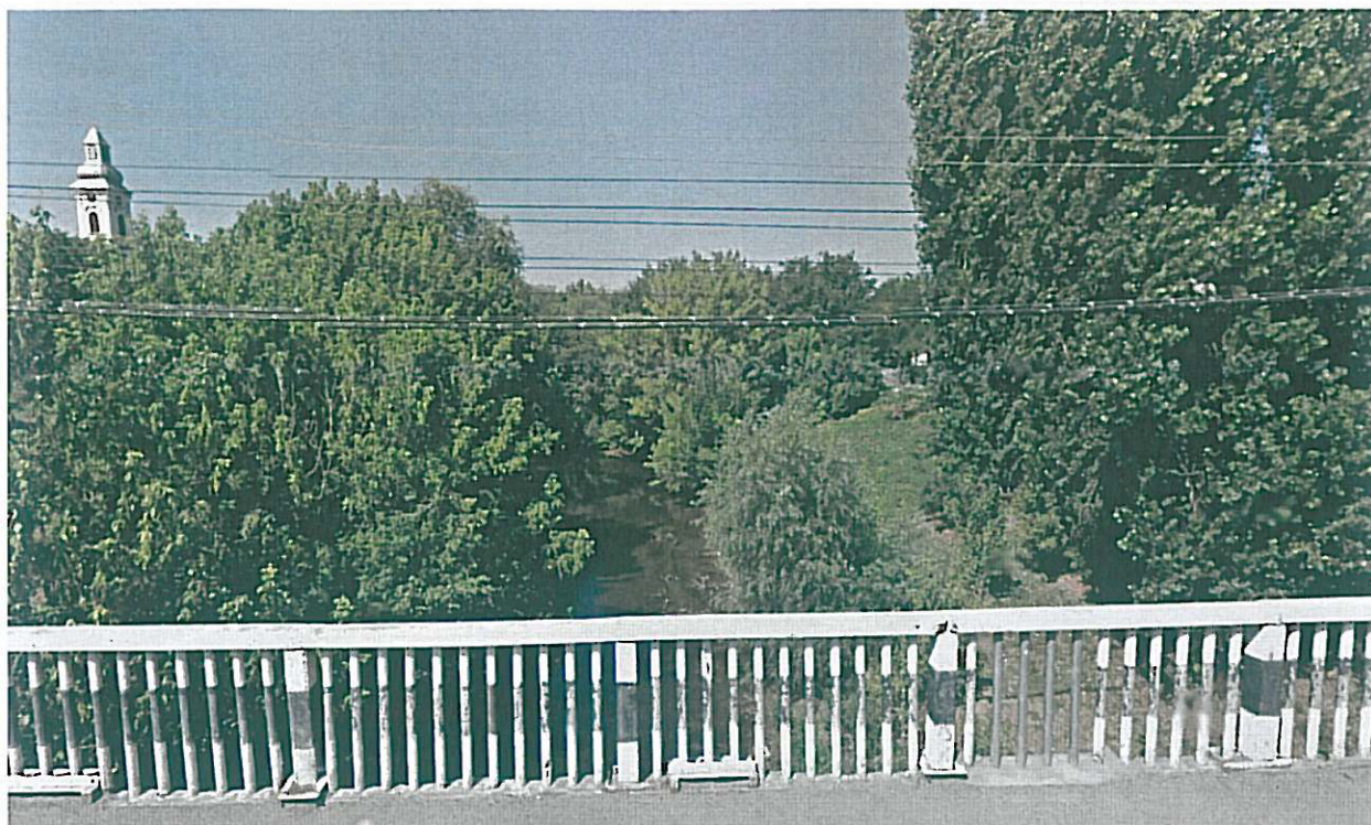
Vedere albie aval de pod
